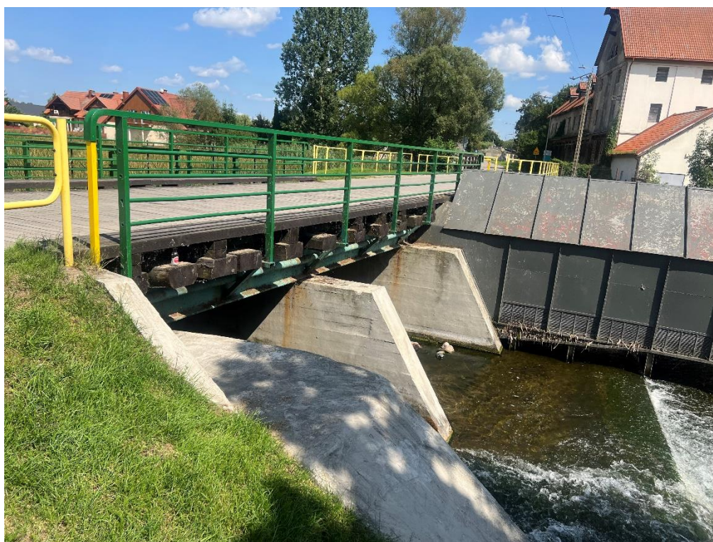
Zdj. 17 Zacieki na betonowych filarach.
