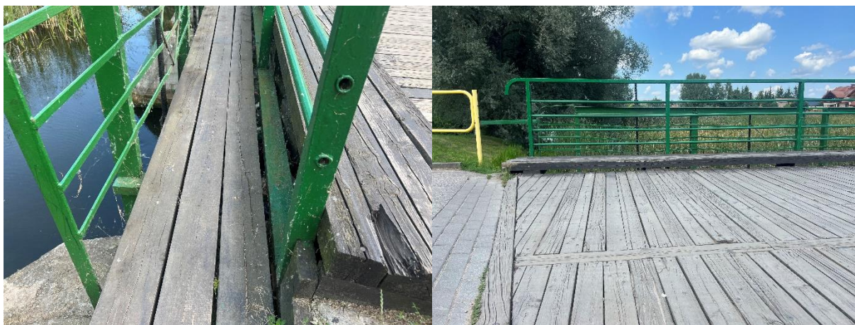
Zdj. 18 Ubytki materiału.
