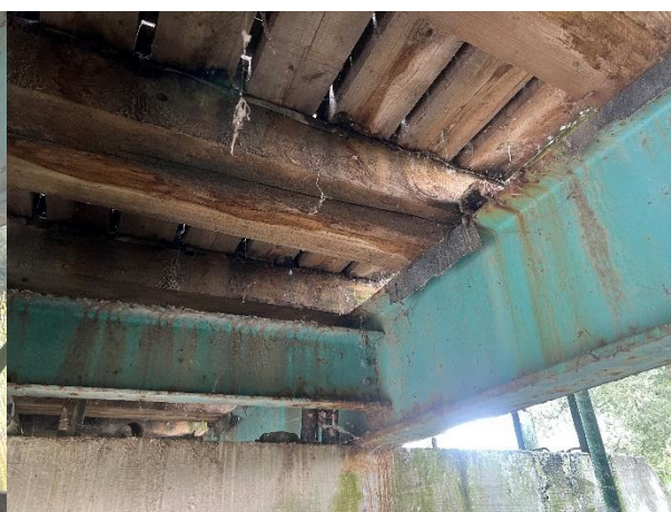
Zdj. 8 Korozja powierzchniowa stalowych dźwigarów.
