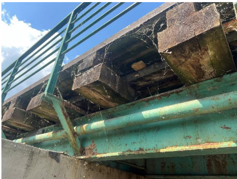
Zdj. 11 Korozja drewnianych elementów pomostu.
