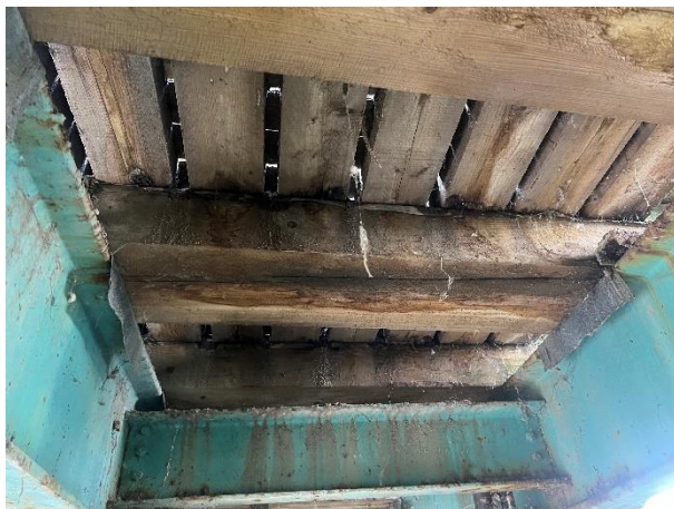
Zdj. 9 Korozja drewnianych elementów pomostu.
