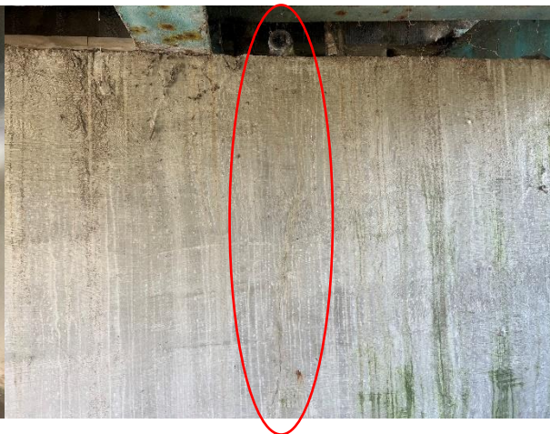
Zdj. 16 Pionowa rysa filara prawobrzeżnego.
