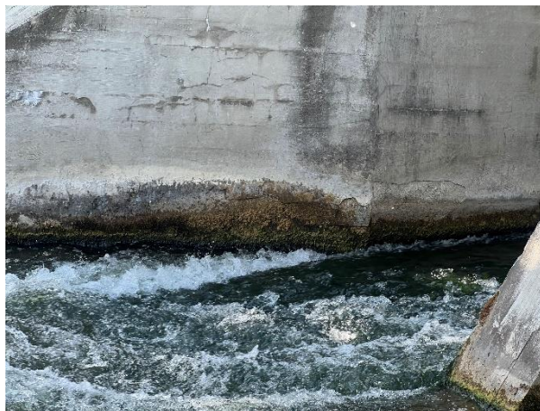
Zdj. 12 Lokalna korozja betonu, ubytki.
