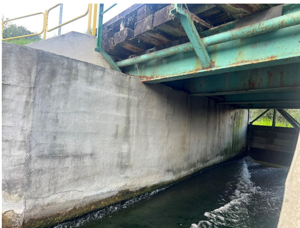
Zdj. 14 Zacieki, korozja betonu.
