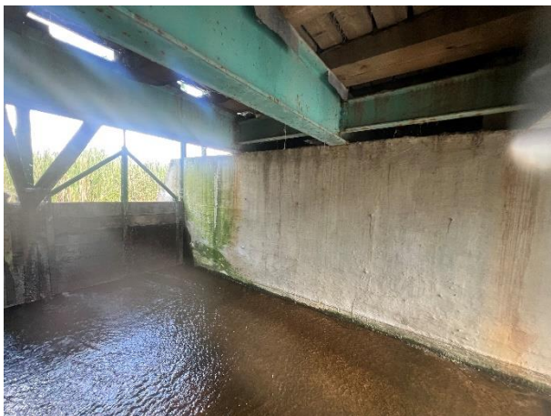
Zdj. 15 Zacieki na powierzchniach filarów.
