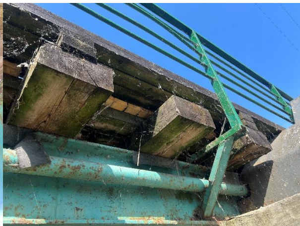
Zdj. 10 Korozja drewnianych elementów pomostu.
