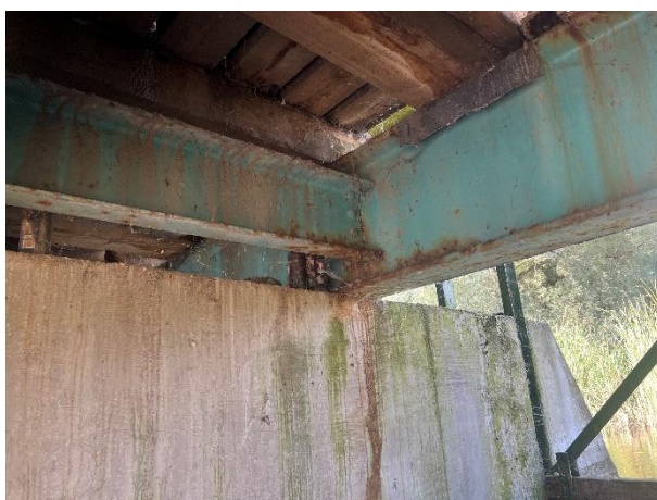
Zdj. 7 Korozja powierzchniowa stalowych dźwigarów.
