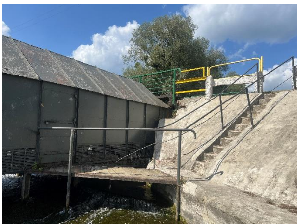
Zdj. 23 Schody skarpowe, betonowe umocnienie stożków.
